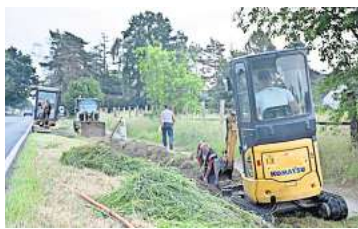
An der L 383 wird Glasfaser für das Heisterholz verlegt. FOTO: LAUBER
